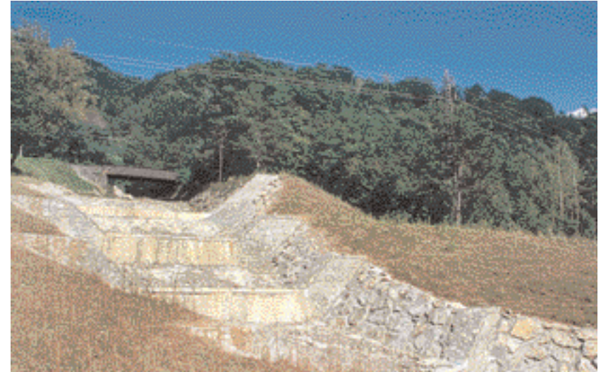
Sistemazione dell'alveo di un torrente, Alpi Giulie
