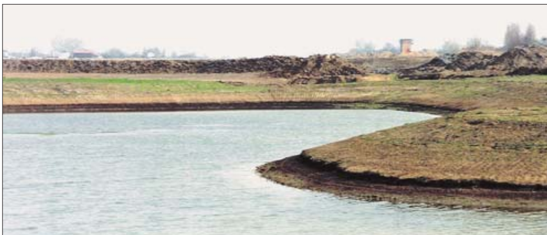
Problemi d'erosione in un'area umida possono avvenire per la natura particolare dei terreni, per la presenza di fetch troppo lunghi, per la pendenza troppo ripida delle sponde.
