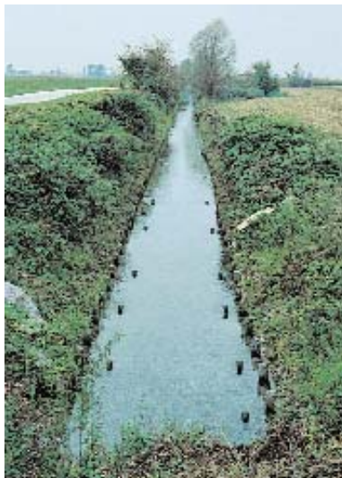
Canalizzazioni in area di fontanili (Lombardia)
