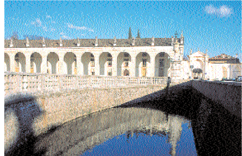
Le vasche della Villa Manin di Passariano (Friuli), alimentate da acque di risorgiva
